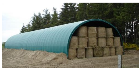
Stockage fourrage ou matériel
